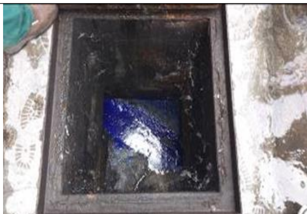
Foto No. 07. Detalle de la caja de inspección externa de agua lluvia donde se observa la descarga de la presunta sustancia peligrosa TINTA SUNONE HQ CYAN
